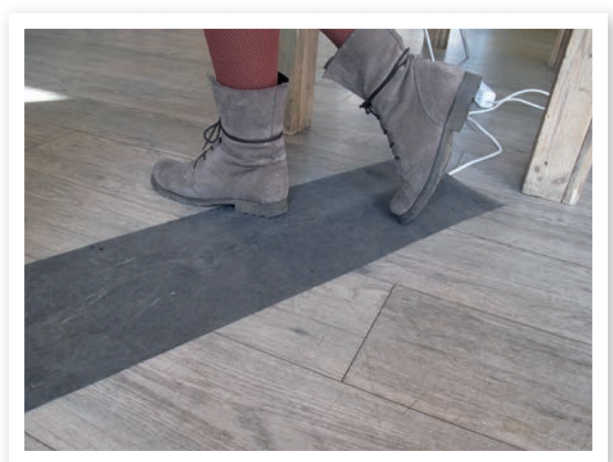
Veilig: snoeren afgedekt met kabelmatten
